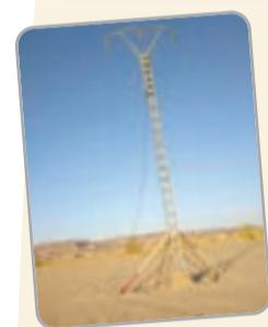
يهدى عمود كهربائي بقطع الكهرباء عن قرية كاملو في جانت، حيث أن عمود الضغط المتوسط التي يتزود بواسطته سكان تين الكوكم الحدودية بولاية جانت، مهدى بالسقوط، ورغم مرور أشهر على وضعية العمود الذي تم دعمه بالشكل الغريب الظاهر في الصورة حتى لا يسقط ويحدث كارثة بسبب حمله لتوتر يصل 3000 فولط، إلا ان سقوطه الوشيك أصبح مسألة وقت، إذ مجرد هبوط رياح بالمنطقة سيكون مصيره السقوط، وحرمان المنطقة الحدودية من الكهرباء والخطر الذي قد يتسبب فيه التوتر الكبير الذي يحمله.
